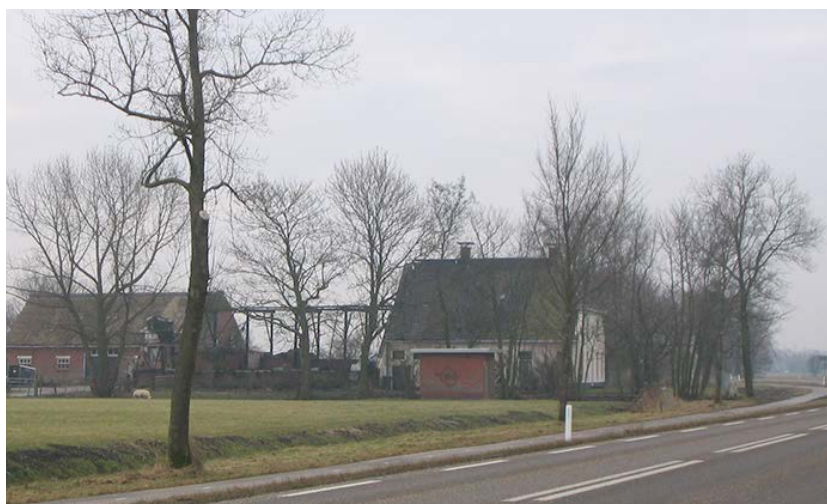
De restanten van de schuur achter het voorhuis op de ochtend van 13 februari 2006 (foto Reina de Lange)
